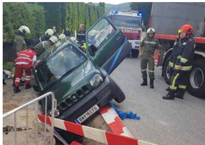
Pkw stürzte in Baugrube
