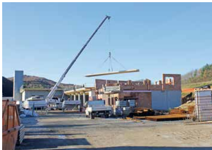
Bautätigkeiten für das neue FF-Haus von Alland
