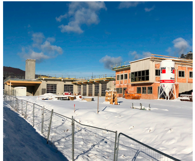
Auf diesem Foto liegt noch Schnee, doch im Herbst, wenn die ersten Blätter fallen, soll der Neubau eröffnet werden. Foto: Marktgemeinde Alland
